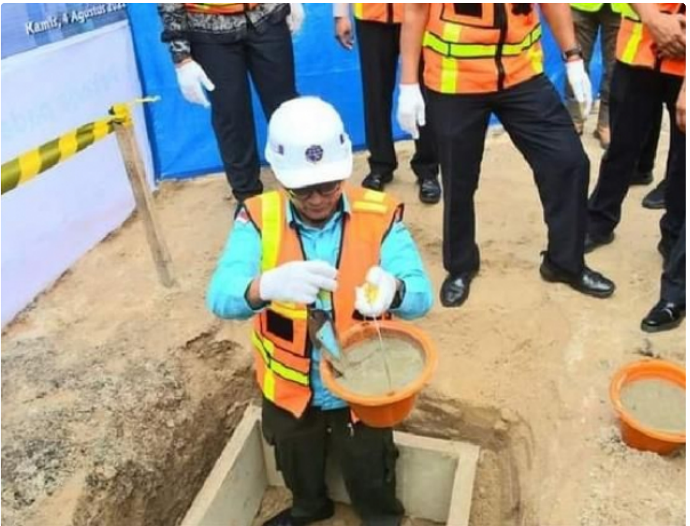
Pembangunan Shelter Kereta Api
